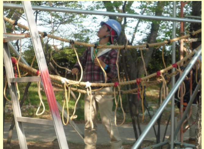
モンキーブリッジ撤収。 万が一に備えてヘルメット着用…
