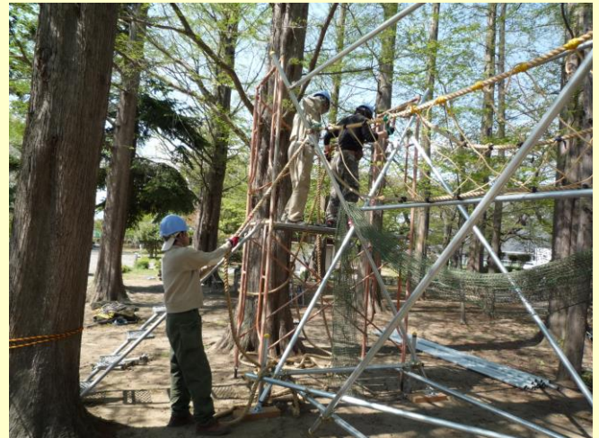
完成に近づいていくモンキーブリッジ。
